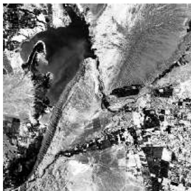
Figura 1. Dique de Ullún San Juan (Argentina)
